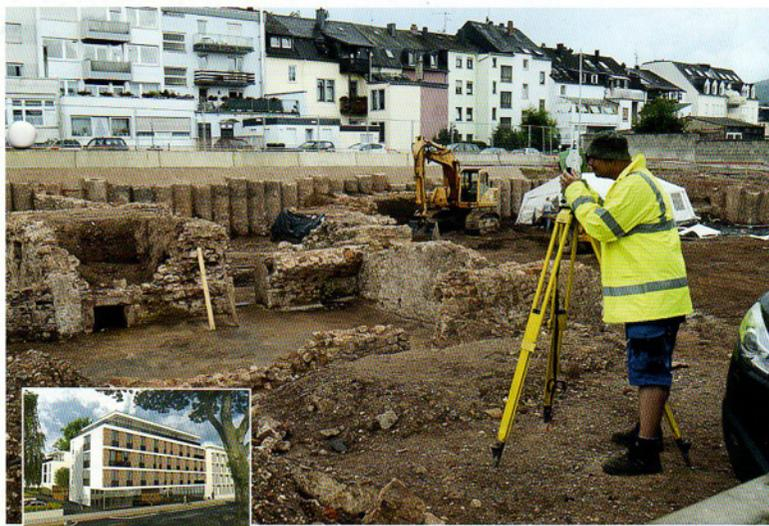
Vermessung mittelalterlicher Keller mit dem Tachymeter (Mark Kronauer)
